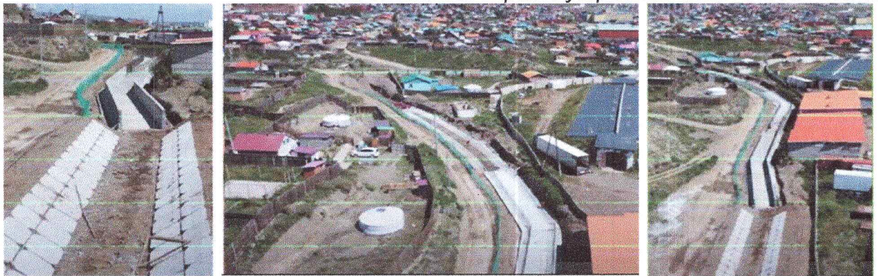
Зураг 28. Шар хад, Толгойт дэд төвийн 3.8 км үерийн хамгаалалтын сувгийн зураг төсөл батлагдан барилга угсралтын ажил хийгдэж байна.
